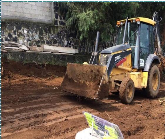
**ILUSTRACIÓN 11**RETROEXCAVADORA EN NIVELACIÓN
