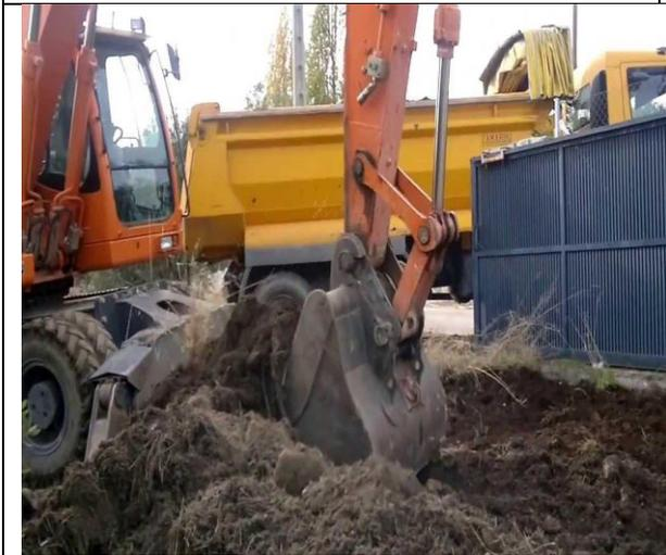
**ILUSTRACIÓN 15 EXCAVADORA EN ZANJEO**
