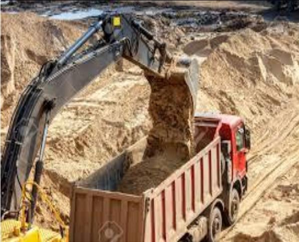
**ILUSTRACIÓN 13 EXCAVADORA EN CARGA DE CAMIÓN**
