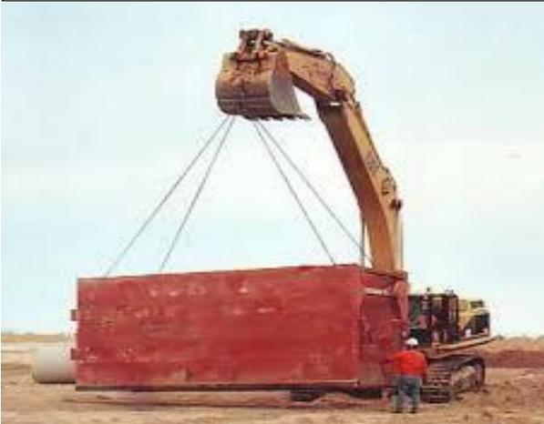
**ILUSTRACIÓN 17 EXCAVADORA EN IZAJE**
