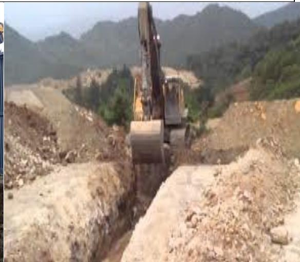
**ILUSTRACIÓN 16 EXCAVADORA EN ZANJEO**
