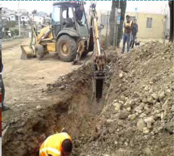
**ILUSTRACIÓN 8**RETROEXCAVADORA EN ZANJEO
