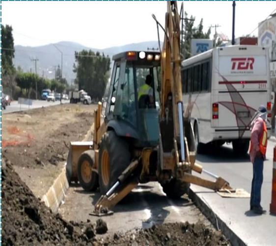
**ILUSTRACIÓN 7**RETROEXCAVADORA EN ZANJEO
