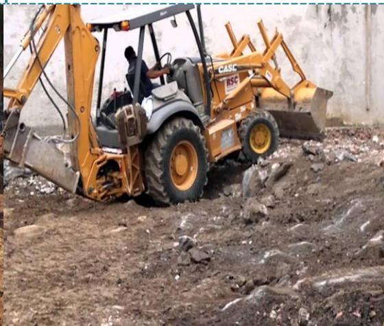
**ILUSTRACIÓN 12**RETROEXCAVADORA EN NIVELACIÓN
